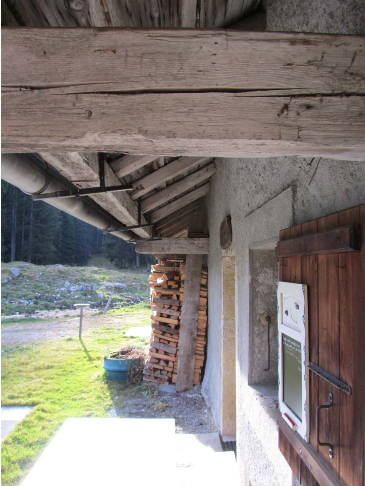
La poutraison de l'avant-toit est d'une solidité à toute épreuve.
